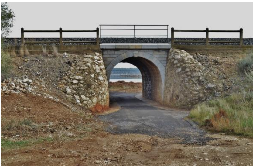
☞ Photographie : Passage routier sous voie ferrée
